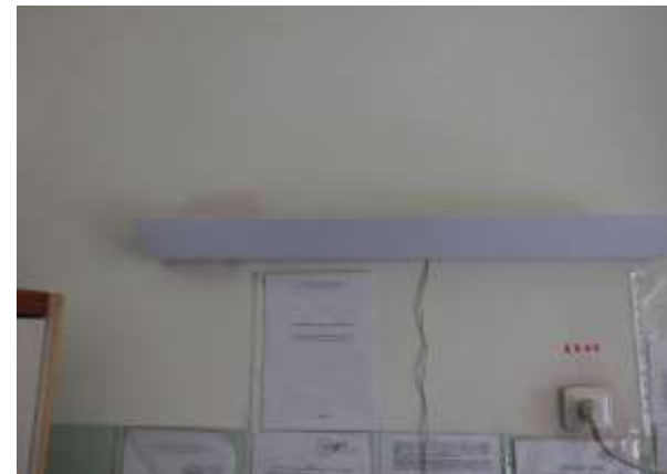
Бактеріоцидна лампа закритого типу – 2 шт. на суму
